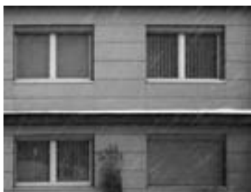
Obr. 4 Všechna okna domu na této fotografii jsou vybavena vnitřními vertikálními žaluziemi a venkovními roletami. Na levém horním okně je vertikální žaluzie zavřená (vpravo otevřená) a u pravého spodního okna je zavřená venkovní roleta (zatímco vlevo dole je otevřená).
