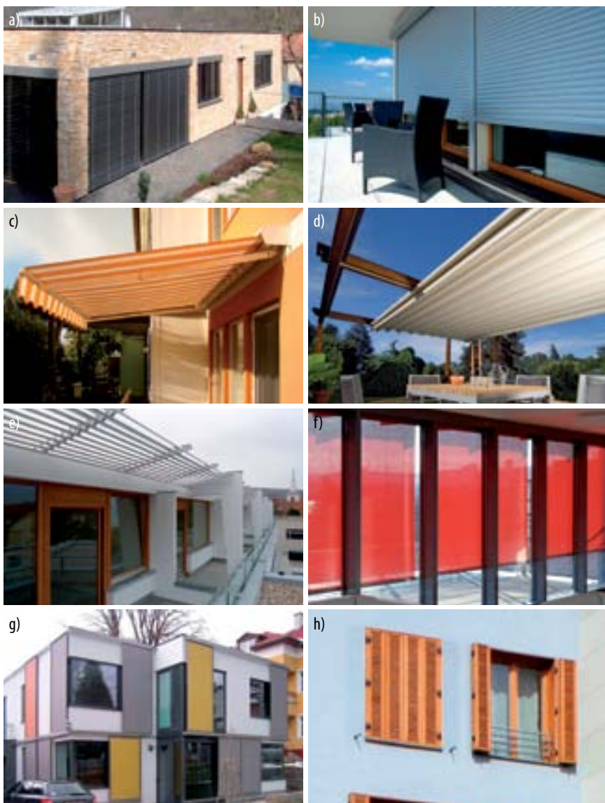
Obř. 6 a) Venkovní řaluzie, b) venkovní roleta, c) markýza, d) pergola, e) slunolam, f) látková fasádní clona (použitý materiál – screen), g) fasádní panel, h) okenice
