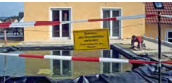
Obr. 2.10 Bezpečnostní opatření jsou nevyhnutelná již v průběhu výstavby
