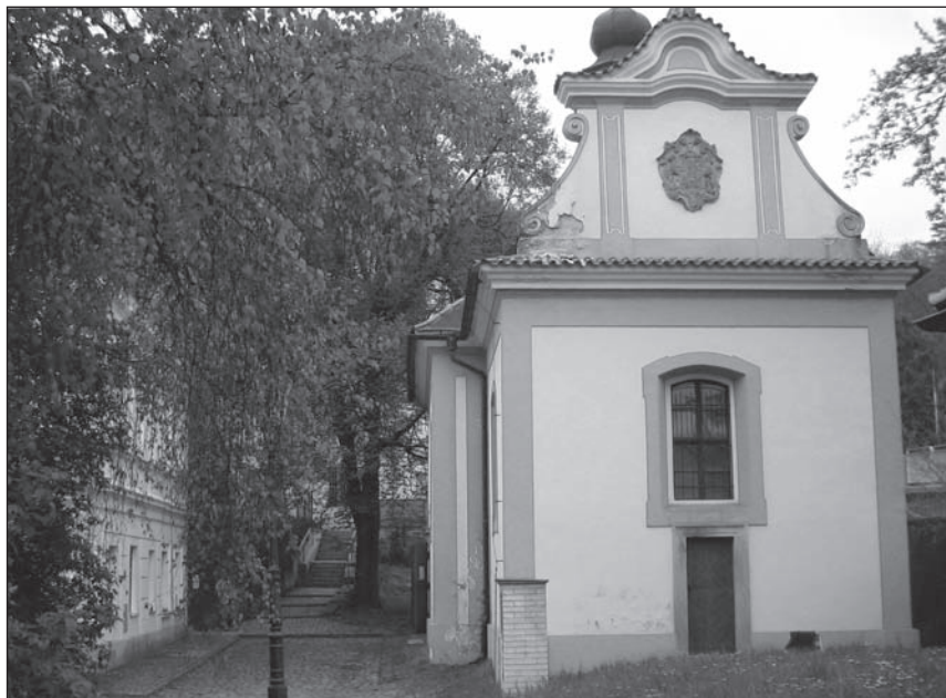
Opravená kaple v současné Malé Chuchli. Foto M. Kubík
