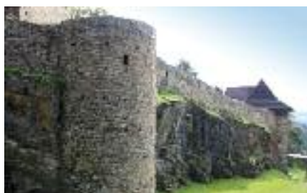
Bašta a hradní příkop (Velhartice)
