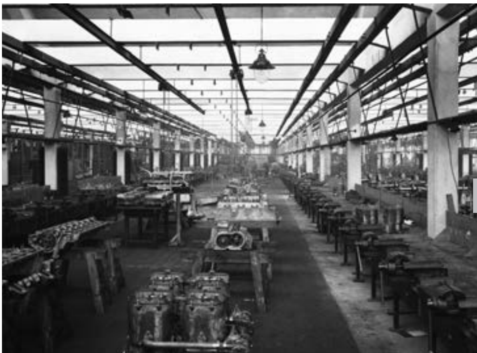
Pohled na montáž agregátů, vpředu čtyřválnce lehčího typu traktoru „U“, v pozadí kliková skříň šestiválnce „Z“. Bloky válců a hlavy byly pro oba typy společné
