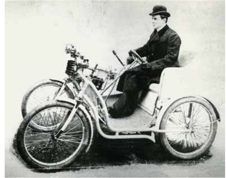
Další krůček ve dvou stopách vznikl spojením dvou motocyklových rámu s pohonem kapalinou chlazeným motorem L&K
