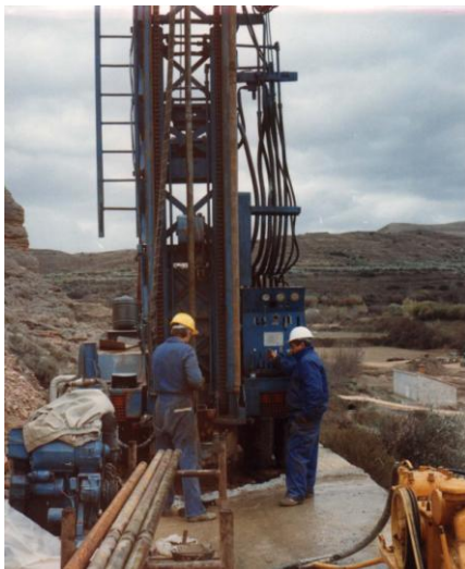
Geotechnický dozor při provádění vodních tlakových zkoušek propustnosti při výstavbě přehrady Val u Tarrazony, provincie Zarragoza. Foto Otto Horský, 1993.
