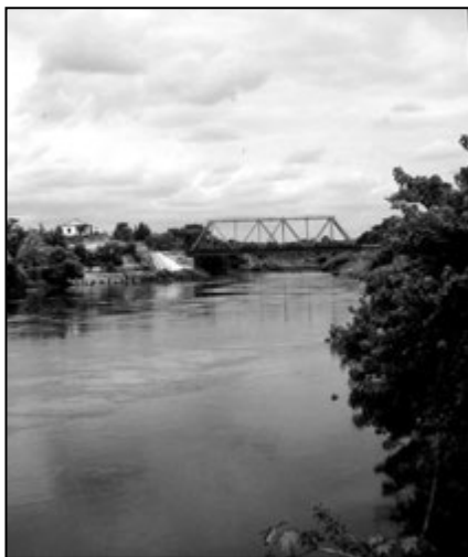
▲ Pohled z pod mostu silničního na most železniční
