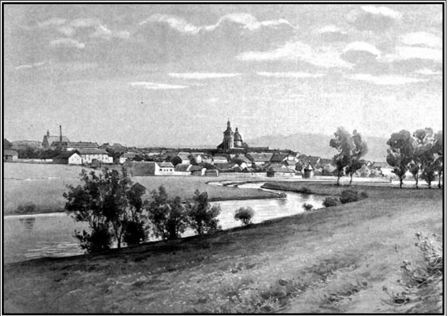
Celkový pohled na Havlíčkův Brod na sklonku 19. století.
