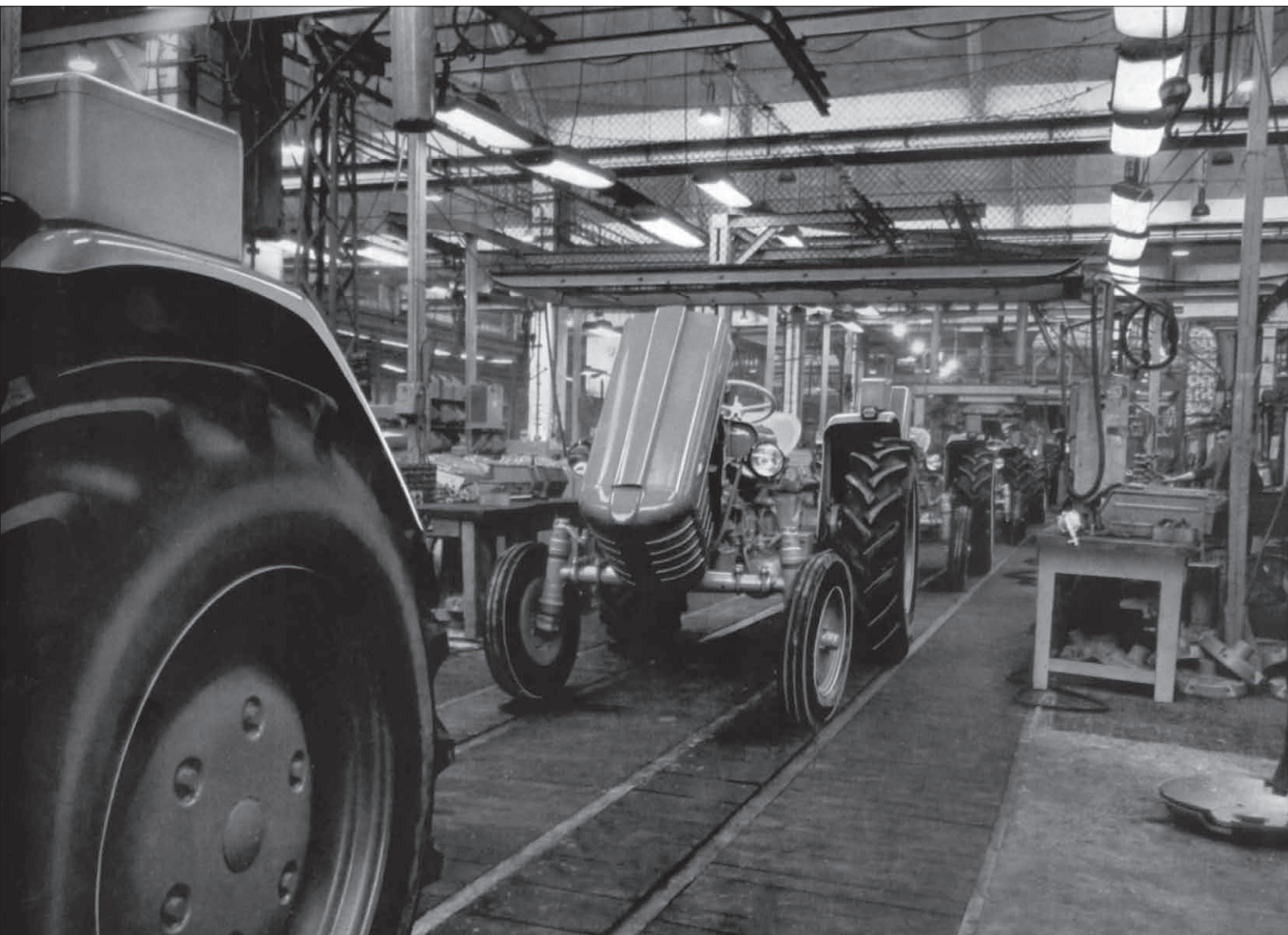
Montáž traktorů Zetor první unifikované řady probíhala od roku 1960
