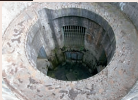
Pohled do vybetonovaného jádra pro otočnou a výsuvnou dělovou věž Horymír
