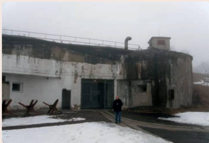
Vstupní objekt tvrze Hůrka, již zbvavený dodatečně dostavěné montované haly před vstupem.
