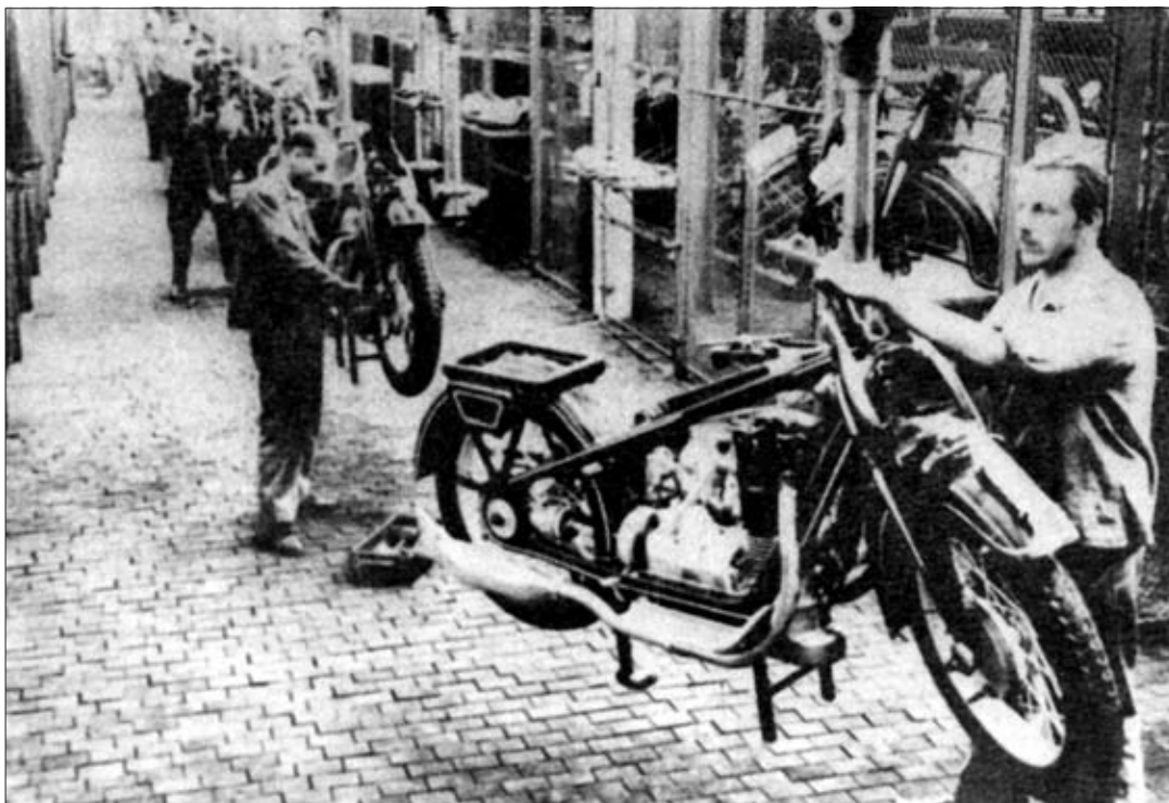
Tak vznikaly půllitrové Jawy na počátku třicátých let. Na obrázku je dokončována montáž modernizované Jawy 500 OHV
