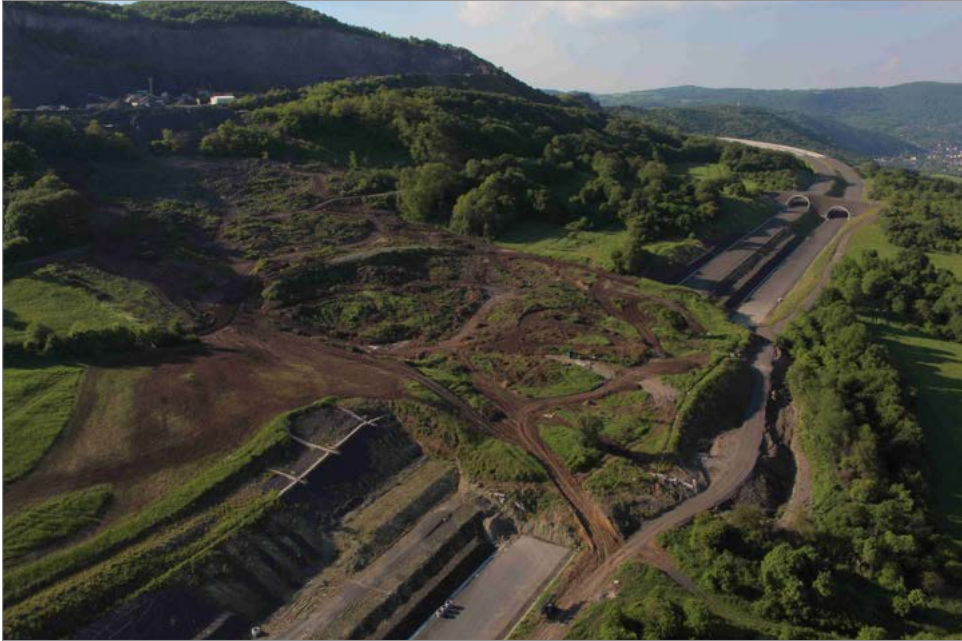
Obrázek 5.1 Letecká fotografie sesuvu na dálnici D8 z dronu pro účely dokumentace aktuálního stavu
