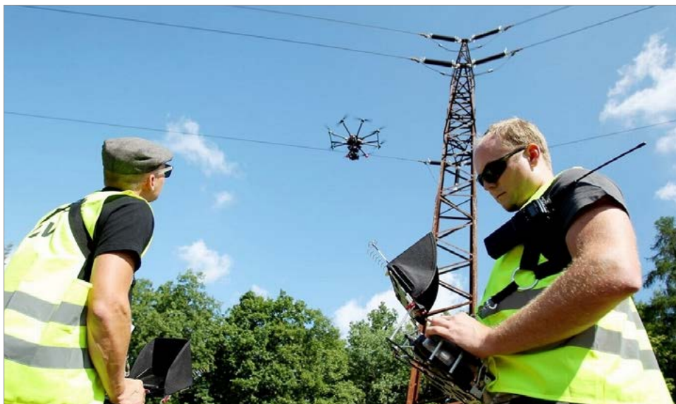
Obrázek 5.7 Pilot a operátor využívají dron pro monitoring případného poškození sloupů elektrického vedení
