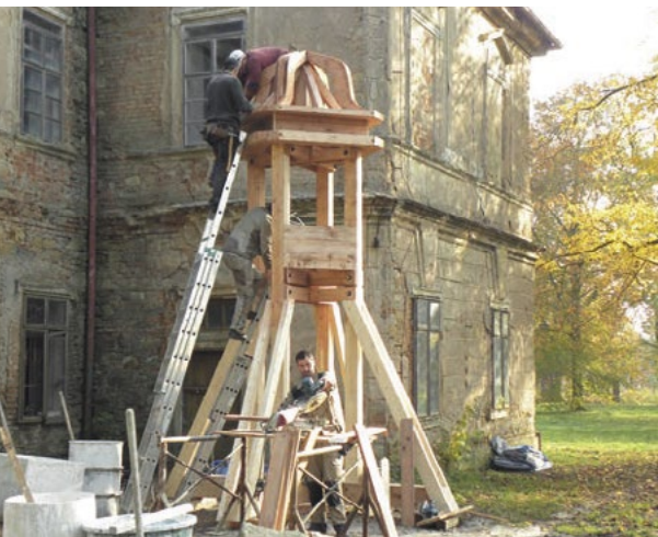
Příprava konstrukce nové zvoničky před osazením na krov.
