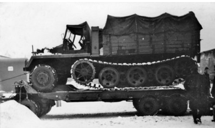
Tatra 809 PPT-8 (ev. č. 522 437) při zkouškách podvalníku P-20, květen 1955 [1]
