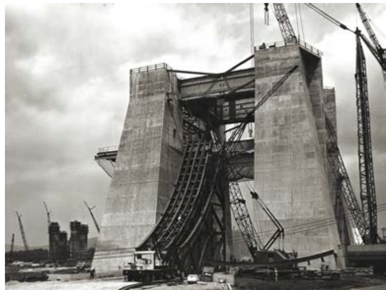
Výstavba testovacích stavů v Marshallově kosmickém středisku (Alabama). Na snímku zařízení 4670 alias S-IC Test Stand. Na něm pak 16. května 1965 došlo k prvnímu zážehu svazku pěti motorů F-1.
