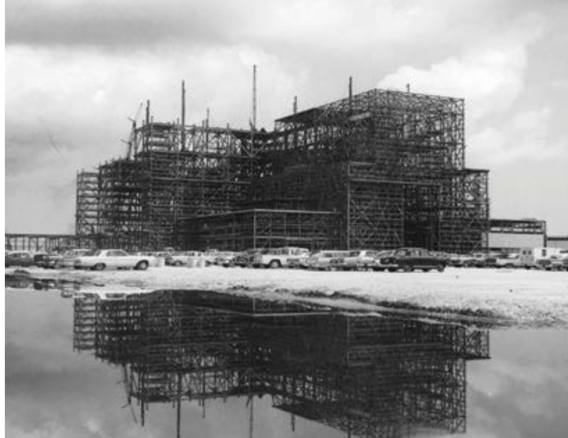
Na konstrukci hangáru VAB bylo spotřebováno 98 590 t oceli. Vpředu je pak vidět břeh plavebního kanálu sloužícího k zásobování stavby. Ten má šířku nejméně 38 m, hloubku 3 m, délku i s odbočkami 20 km a pro jeho vybudování bylo přemístěno sedm miliónů tun zeminy.
