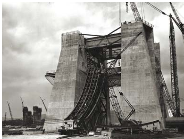
Výstavba testovacích stavov v Marshallovom kozmickom stredisku (Alabama). Na snímke zariadenie 4670 alias S-IC Test Stand. Na ňom potom 16. mája 1965 došlo k prvému zážihu zväzkov piatich motorov F-1.
