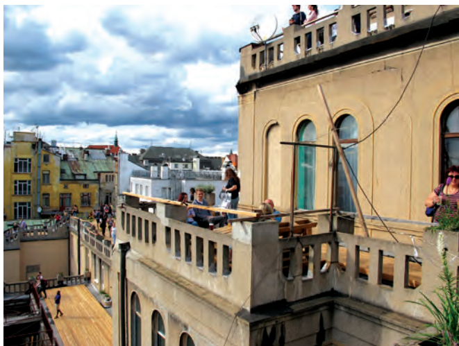
▲ Střecha Lucerny je labyrintem schodišť a teras
