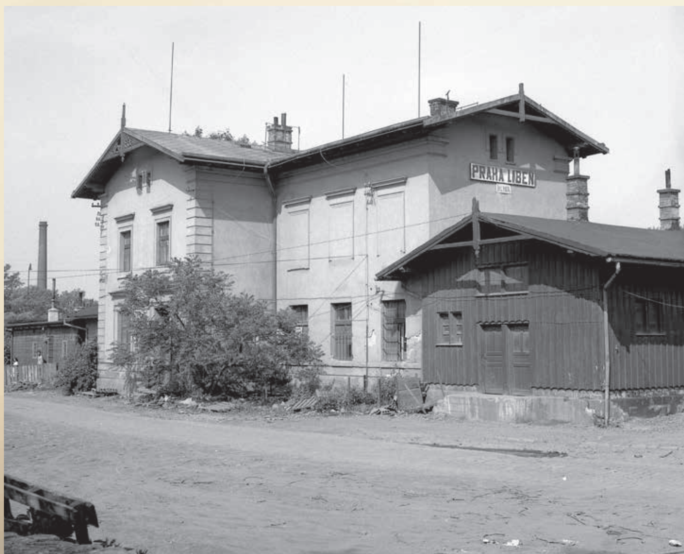
Staniční budova Praha Libeň dolní nádraží, pohled z přednádraží, 3. 6. 1984, foto Petr Ovsenák.
