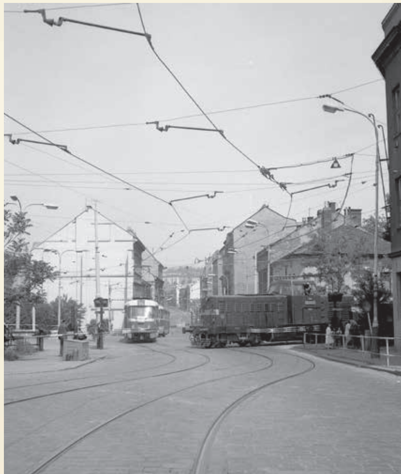
3. června 1984 projíždí poslední vlak s cestujícími z Vysočan na Těšnov přejezdem pod Palmovkou u stanice Libeň dolní nádraží. Na průjezd lokomotivy T 444.0075, vedené strojvedoucím Pavlem Kolouchem, čeká tramvaj linky č. 14, foto Petr Ovsenák.
