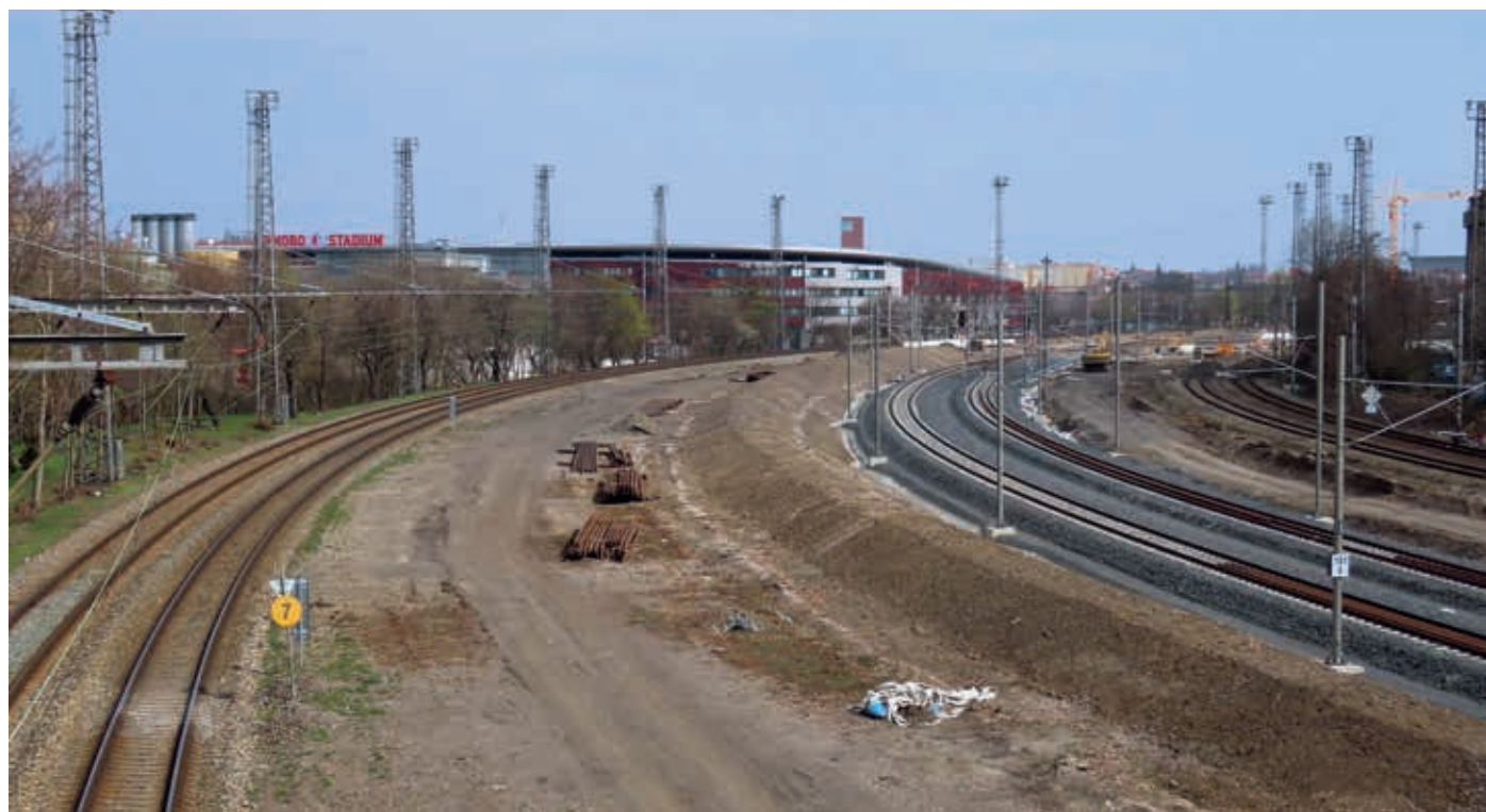
Pohled ze železného mostu v Moskevské ulici na odjezdovou skupinu seřaďovacího nádraží. Nahoře v šedesátých letech za plného provozu, uprostřed před několika lety a dole v roce 2019. Zcela vlevo je na obrázcích trať z Vršovic do Hostivaře přes zastávku Strašnice, která v roce 2019 bude nahrazena novou tratí v odjezdové skupině. Vpravo je původní strojová kolej, objíždějící směrové koleje, dnes výjezd z ONJ, foto ČTK sbírka Josef Bosáček, sbírka SUDOP, foto Karel Smejkal koridory.cz.
