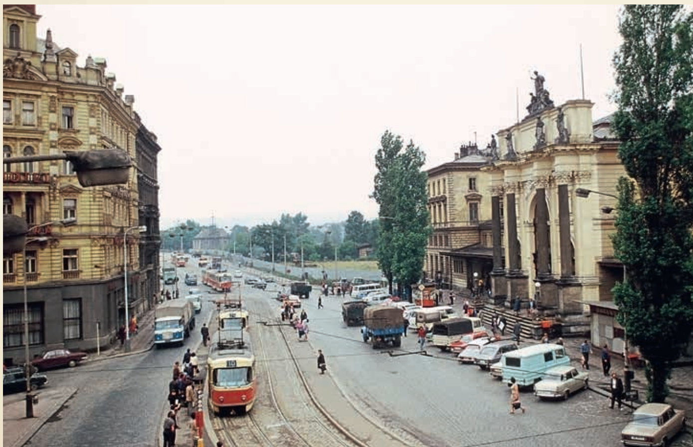
Pohled z domu směrem k Hlávkovu mostu. Vlevo je hotel Opera, vpravo nádražní budova. Na ulici je rušný provoz, ale stavební ohrada za nádražní budovou již signalizuje bourání nádraží. Snímek ze dne 1. 7. 1972, foto Jiří Bouda, sbírka Josef Bosáček.
