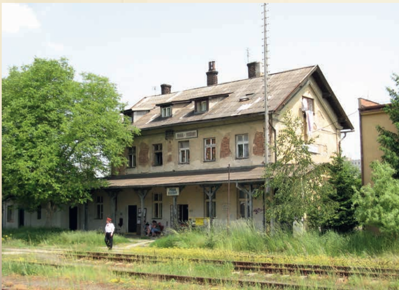
Výpravní budova nádraží Praha Modřany byla ještě v roce 2008 obydlena (31. 5. 2008), foto Petr Ovsenák.
