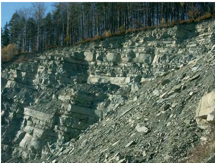
Foto 20. Jednotlivé dílčí příkrovy vnějších Západních Karpat jsou často tvořeny flyšovými sedimenty, pro něž je typické střídání pískovcových lavic s méně mocnými vložkami jílovců nebo prachovců (lom Řeka).
