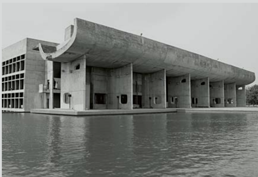
Le Corbusier, budova Národního shromáždění, Kandahár, 1962 Litý beton organických forem vyžaduje přesnou práci tesařů.
