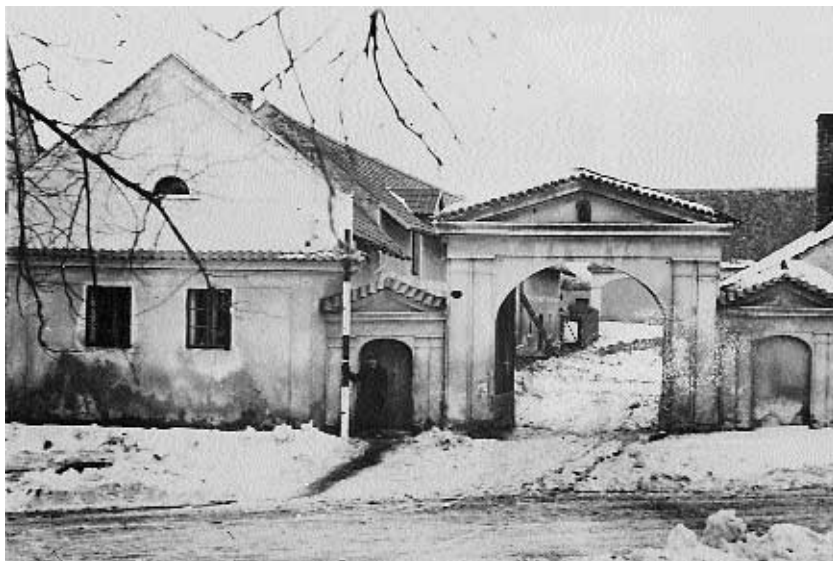
Fotografie zemědělských objektů na území Neveklov, určených k demolicí, pořízená pro Německou osídlovací společnost r. 1942. (Foto: Archiv NZM)
