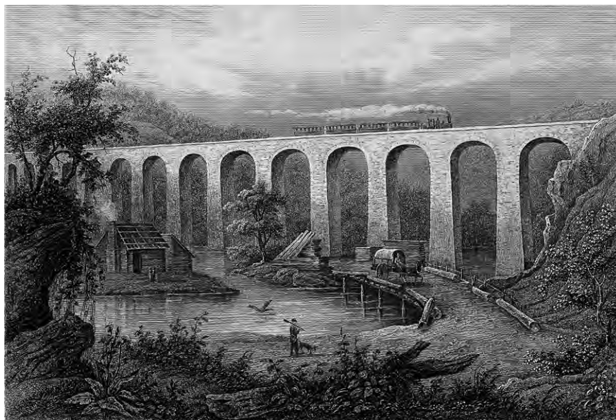
Viadukt Starrucca na erijské dráze
