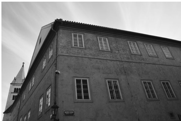
Bývalá konventní budova od jihu, kde se k Jiřské ulici přidává Zlatá ulička
