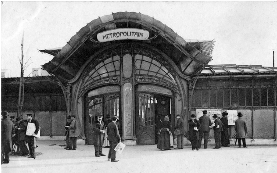
Stanice metra na náměstí Bastily.
