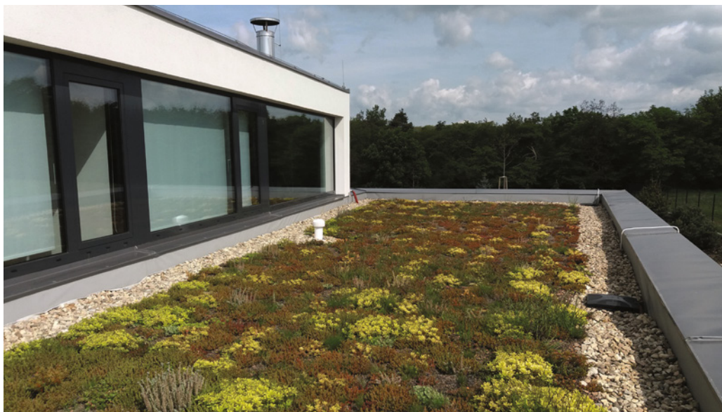
Extenzivní zelená střecha
