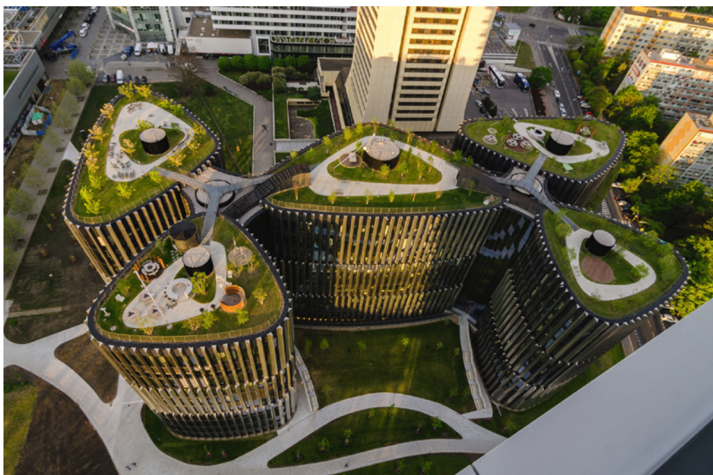
Zelené střechy jsou součástí moderní architektury (Main Point Pankrác, Praha).
