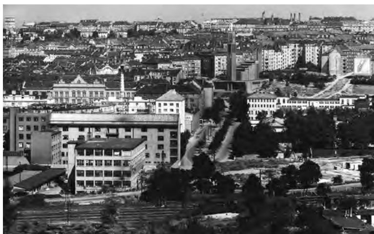
12. Fotografie původního stavu Batovy továrny čp. 949 v dnešní Moskevské ulici (Archiv hl. m. Prahy)
