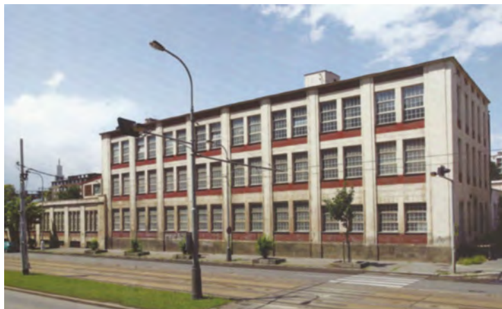
9. Továrna Tesla – původně Heliá na Vršovické ul. před zbořením ( https://www.industrialnistopy.cz )
