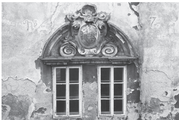
Detail výzdoby na fasádě bývalé jezuitské rezidence pod Chlumkem
