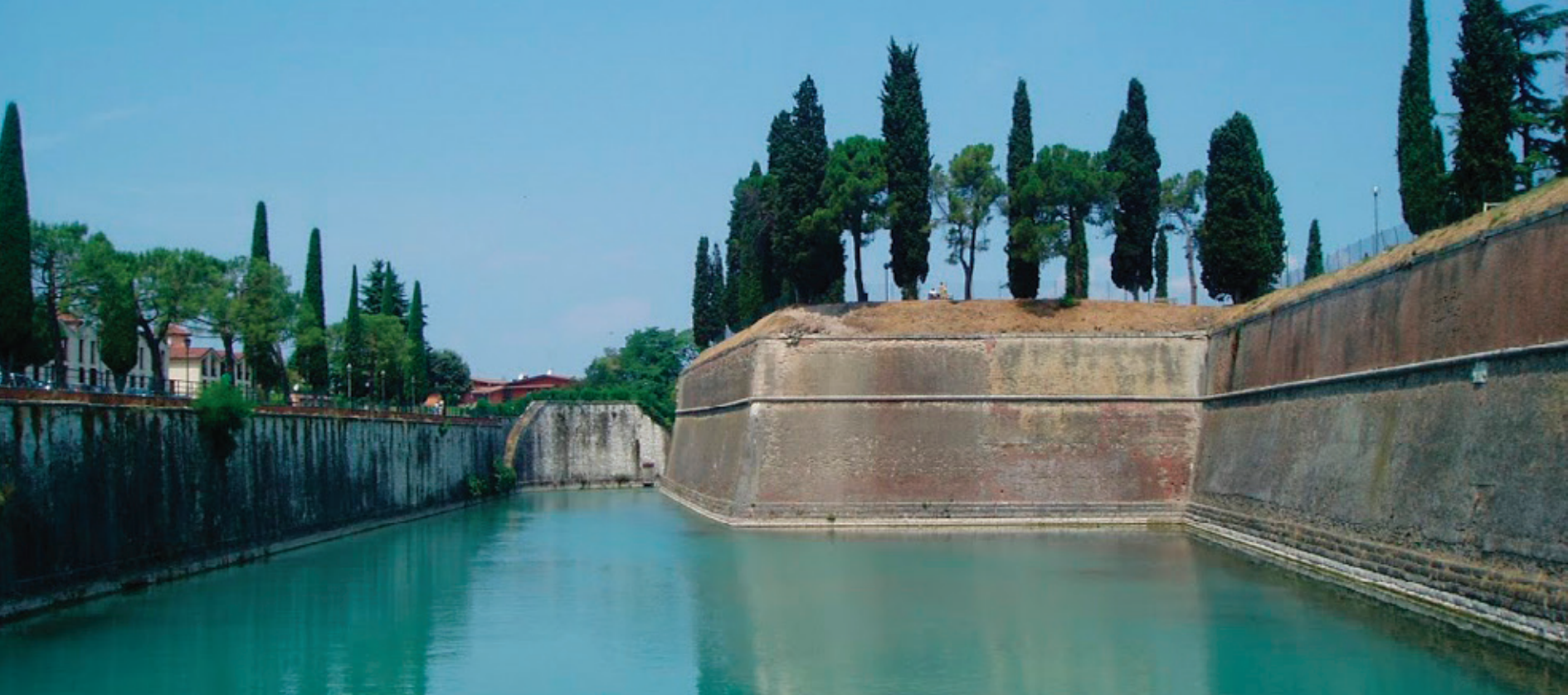
Bastionové opevnění rakouské pevnosti Peschiera v Itálii, která tvořila součást tzv. pevnostního čtyřúhelníku v Itálii. Na fotce je patrný bastion s kurtinou, před kterým leží vodní příkop a kontraeskarpa. 11
