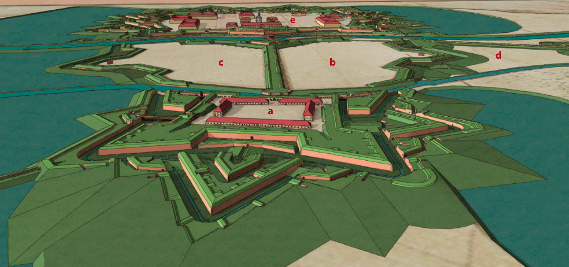
Pohled přes fort Malá pevnost (a) od východu na pevnost Terezín. Za fortem je vidět Dolní (b) a Horní (c) retranchement se Severním předsunutým šípem (d), který byl vybudován až v roce 1809. V pozadí se nachází Hlavní pevnost (e). 53
