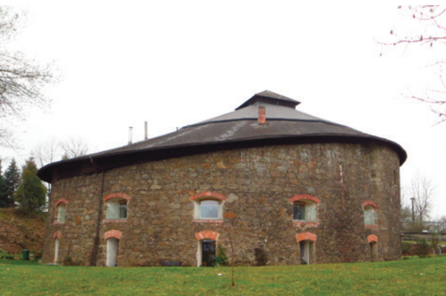
Maxmiliánská věž č. 9, součást pevnosti Linec, byla vybudována v letech 1830 až 1831. Zdejší věže inspirovaly návrh na modernizaci pevnosti Terezín, při které mělo být vystavěno pět konstrukčně podobných věží. Tato věž je už zbavena valu a místo něj se nachází novodobá střelna, střilny po obvodu věže jsou upravené na okna. 22
