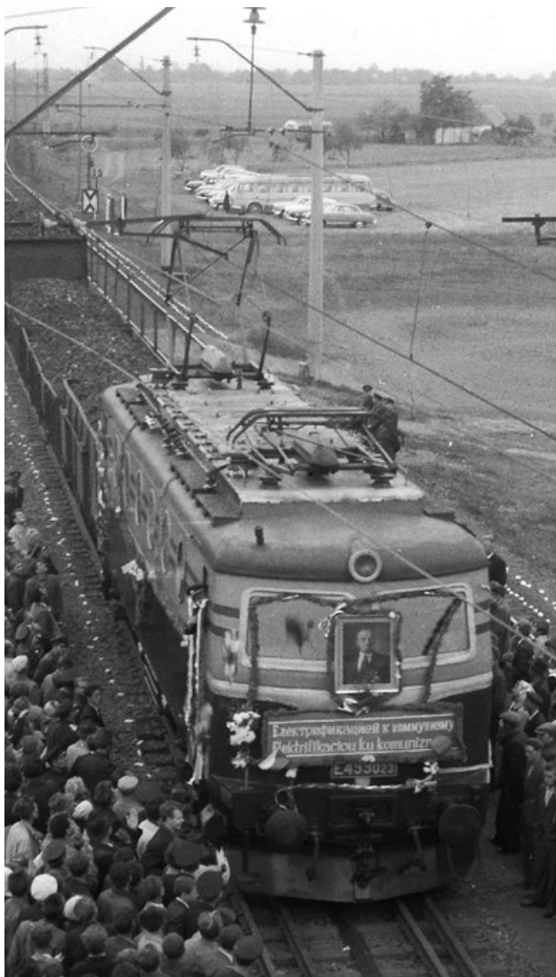
Záběr lokomotivy E 499.023 s nákladním vlakem z 20. října 1962 v rámci zahájení elektrického provozu z Čierné nad Tisou do ukrajinského Čopu
