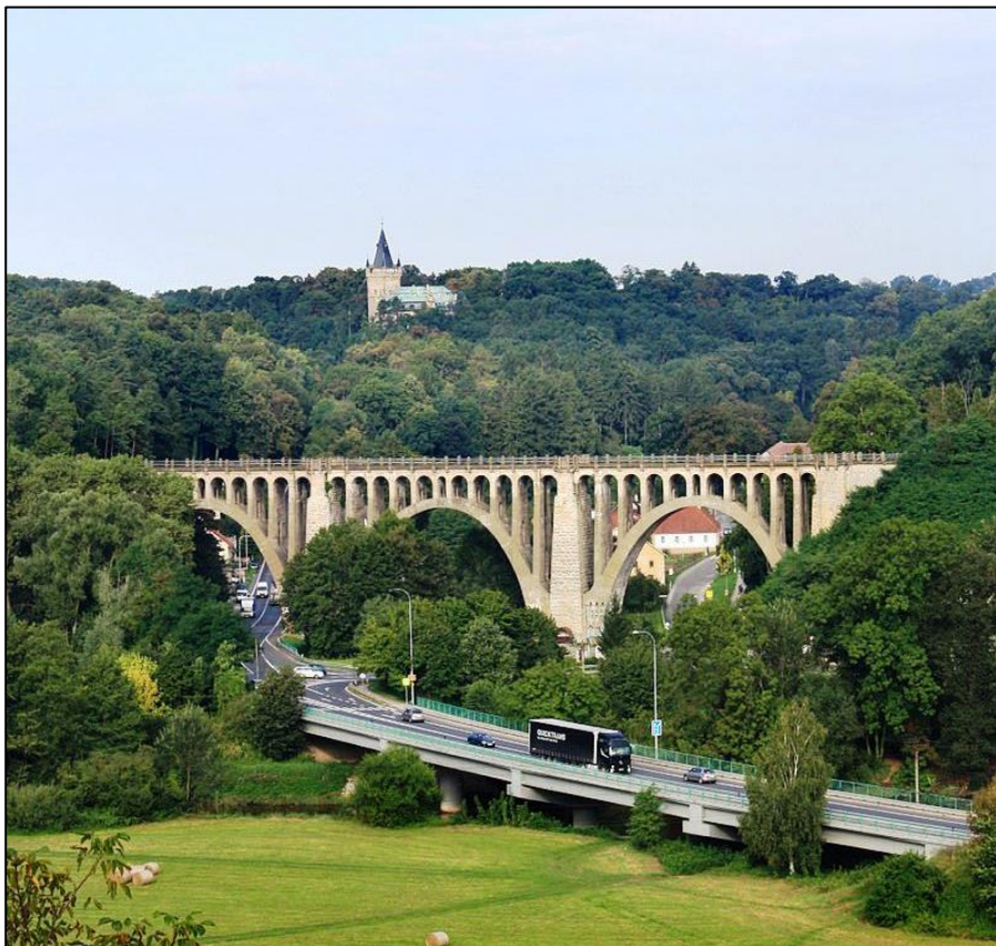
Pohled na viadukt u Krnska, v pozadí zámek Stránov. (Foto: archiv KŽČ)
