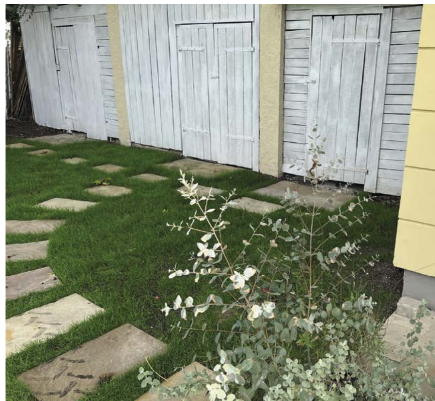
▲ ... stačilo jen trochu opravit střechu, všechny dřevěné části obrousit a natřít na bílo, opravit trochu omítku a vytvořit od kůlen cestičky z kamenů, které zbyly po rekonstrukci domu. Nově zasetý trávník společně s upravenou kůlnou pak z nehezkého místa vytvoří vlastně docela pěkné zákoutí, které zahradu již nehyzdí.
