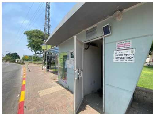
Typický objekt veřejného krytu v jižním Izraeli. Tento je ve městě Sderot a nachází se vedle autobusové zastávky. Na rozdíl od krytu, v němž jsme trávili nálet v Aškelonu, je tento uzavíratelný kovovými dveřmi. Foto: Z. Šmajlerová, 6. 8. 2022.
