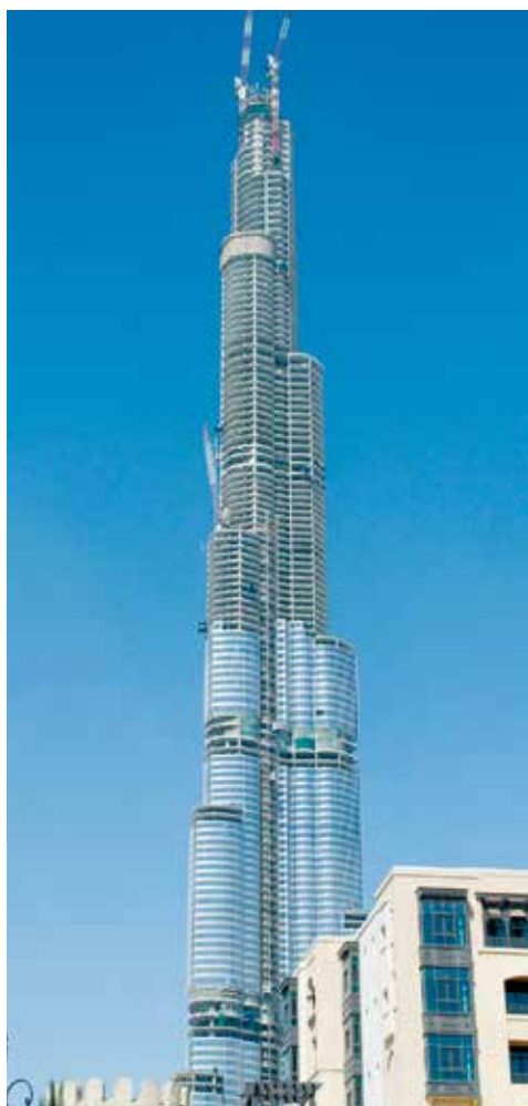
Obr. 1.18 Železobetonová konstrukce výškové budovy Burdž Chalífa během výstavby v roce 2008
