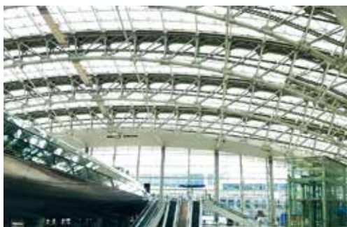
Obr. 1.21 Ocelová konstrukce haly (Incheon, Seoul, Jižní Korea). Příhradové oblouky podepírají zasklení letištní haly
