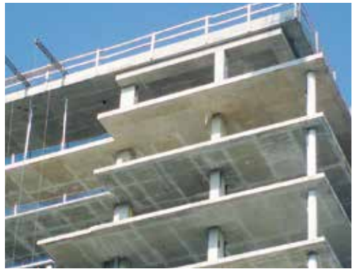
Obr. 1.15 Monolitická železobetonová konstrukce při výstavbě – lokálně podepřená stropní deska s rovným podhledem
