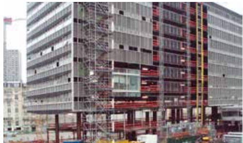
Obr. 1.20 Ocelový vícepodlažní skelet administrativní budovy
