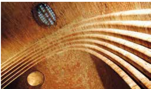
Obr. 1.11 Cihelná klenba
