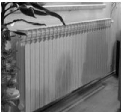
Obr. 9 Hliníkový radiátor výšky 578 mm
