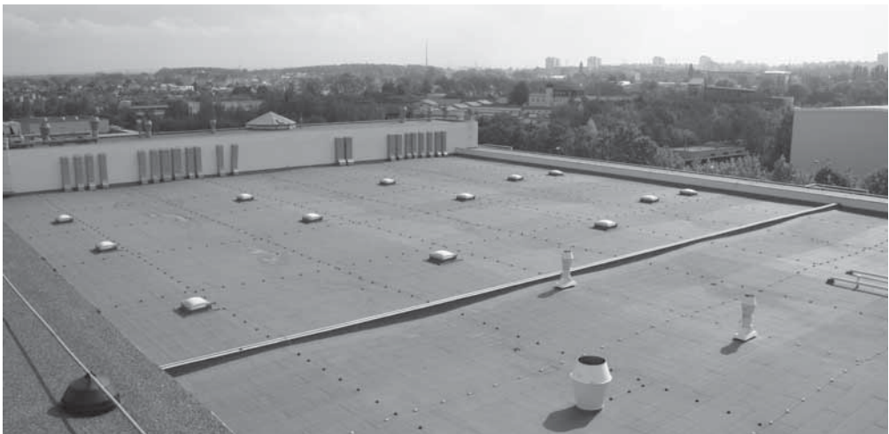
Obr. 1.1 Vodotěsná izolace z asfaltových pásů VEDAG – hala firmy Zentiva v Praze 10 (foto VEDAG – ČR)
