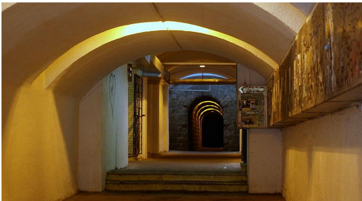
Starý podchod pod nádražím a kolejištěm, dříve spojující ulice U Vinných sklepů a Podnádražní.
