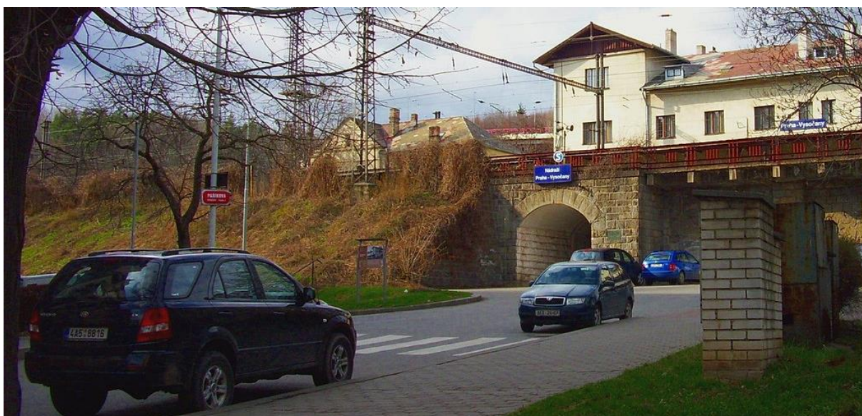
Původní vstup do podchodu ze směru od Vysočan, na jehož místě vznikne nová odbavovací hala.
