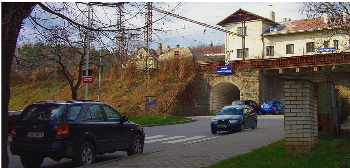
Původní vstup do podchodu ze směru od Vysočan, na jehož místě vznikne nová odbavovací hala.
