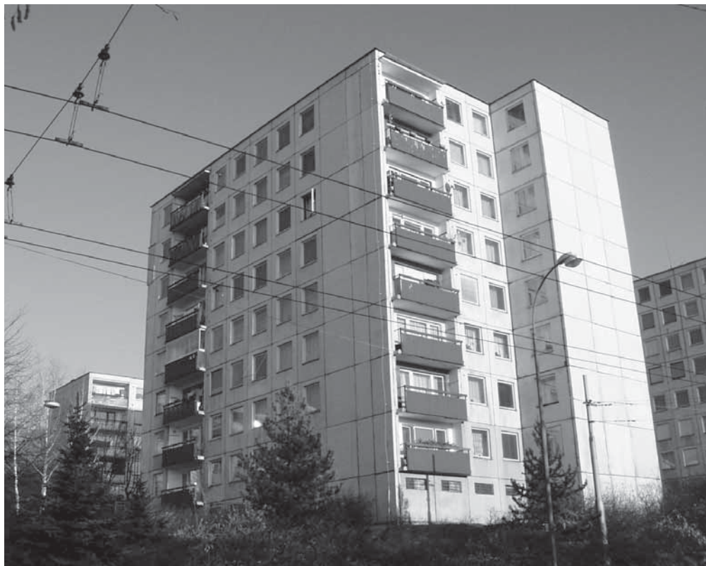
Obr. 4.5 Fasáda bytového domu panelové soustav B 70
