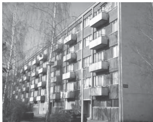
Obr. 4.10 Průčelí domu s balkony východočeské soustavy typu HK s vyzdívanými meziokenními výplněmi
