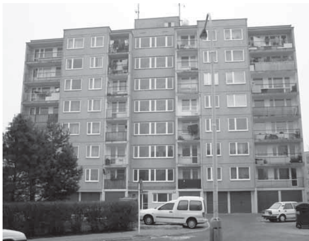
Obr. 4.9 Průčelí domu soustavy VVÚ-ETA
