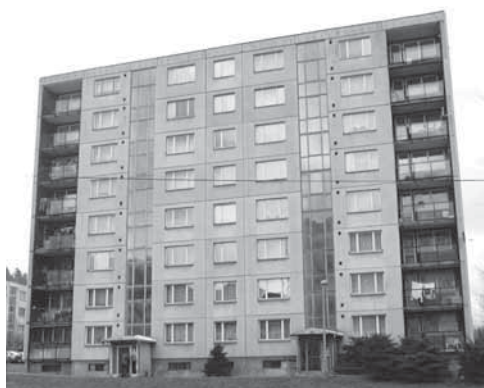
Obr. 4.6 Příklad fasády domu panelové soustavy BA-NKS
