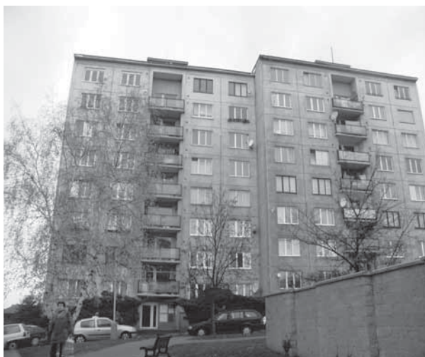
Obr. 4.4 Karlovarská varianta soustavy T 06 B
