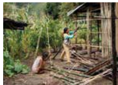
Stavba bambusového domu ve Vietnamu
