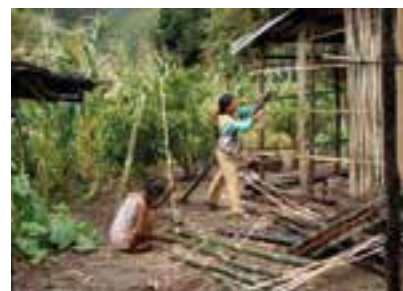
Stavba bambusového domu ve Vietnamu
