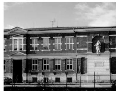
Budova školy (F. Jureček, 1894), Mor. Ostrava
