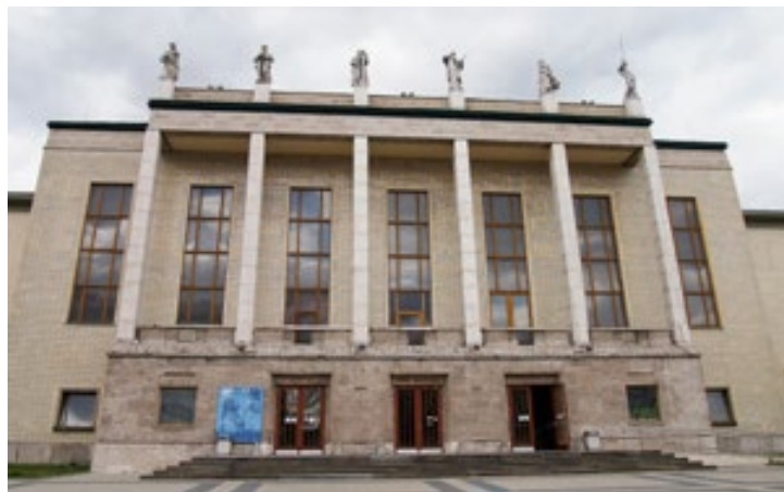
Dům kultury Ostrava. Foto Vít Pokorný, 2020
