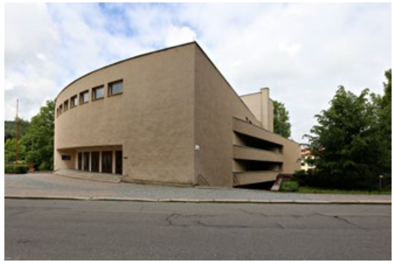
Roškotovo divadlo Ústí nad Orlicí. Foto Dana Čecháková, 2018
