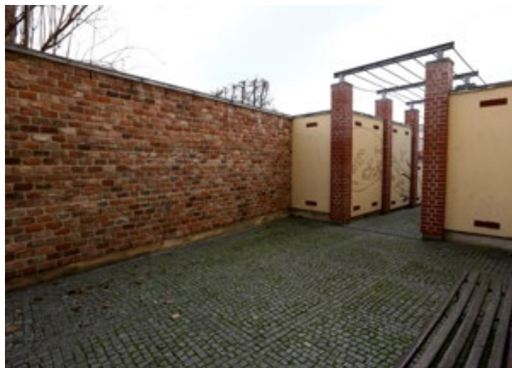
Studio Beseda Hradec Králové. Venkovní kužárna herců za jevištěm, tzv. pečkárna. Foto Dana Čecháková, 2017
