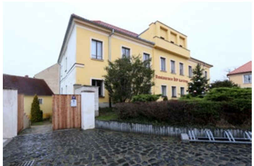
Kulturní dům Říp Roudnice nad Labem. Stav před zásadní rekonstrukcí objektu, uskutečněnou v l. 2018–2020. Foto Dana Čecháková, 2017
