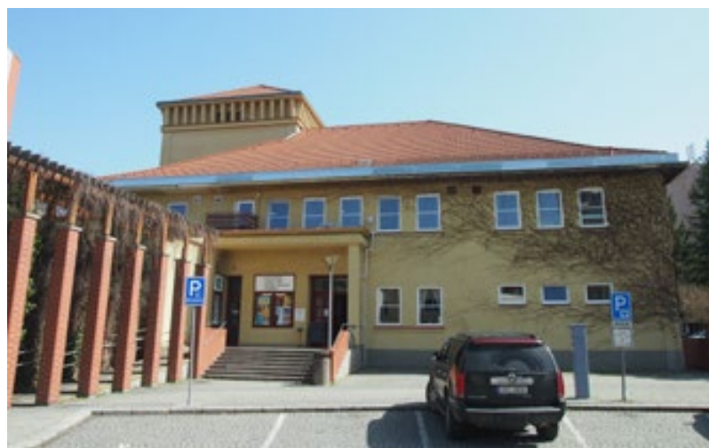
Kulturní dům Sázava. Foto Vít Pokorný, 2018
