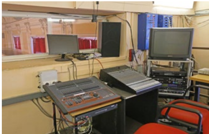
Městský dům Přerov. Zvukařská a osvětlovací kabina. Foto Dana Čecháková, 2017
