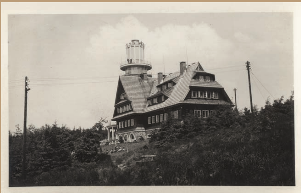
Kramářova chata s nově postavenou rozhlednou. Pohlednice z třicátých let.
