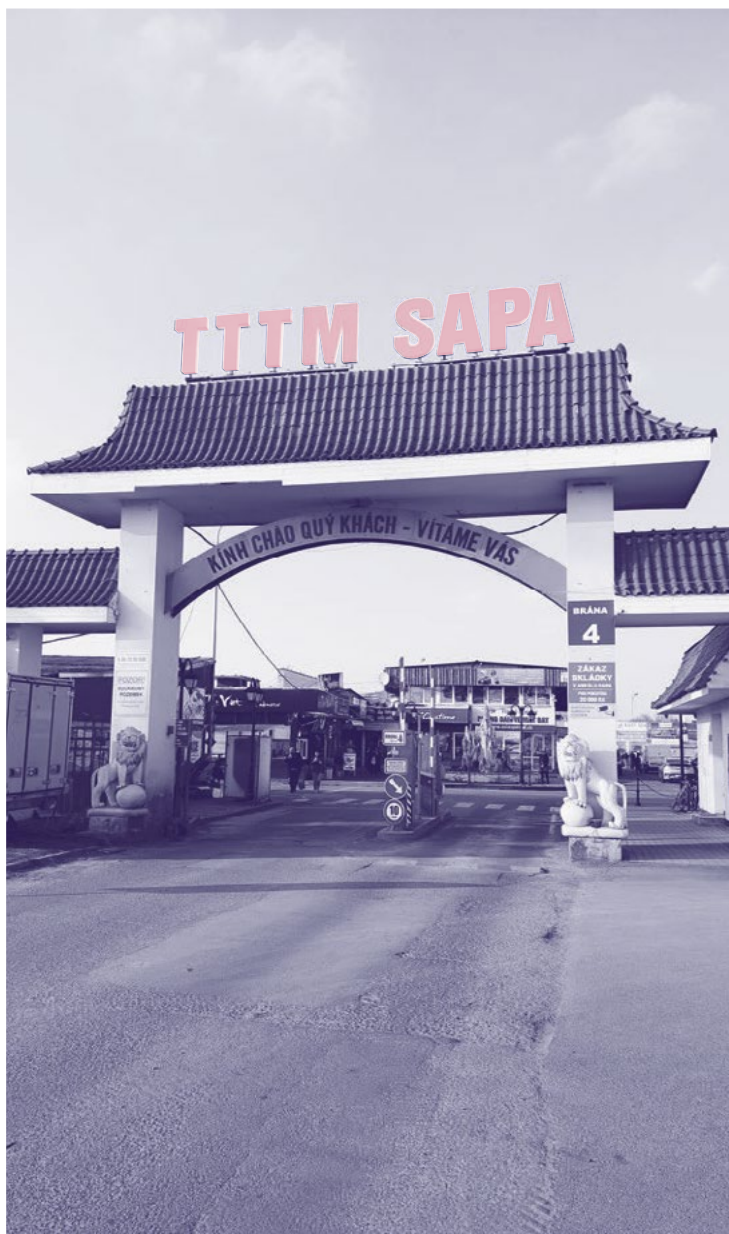
Obchodní centrum Sapa se rozkládá na ploše více než 250 tisíc metrů čtverečních.
