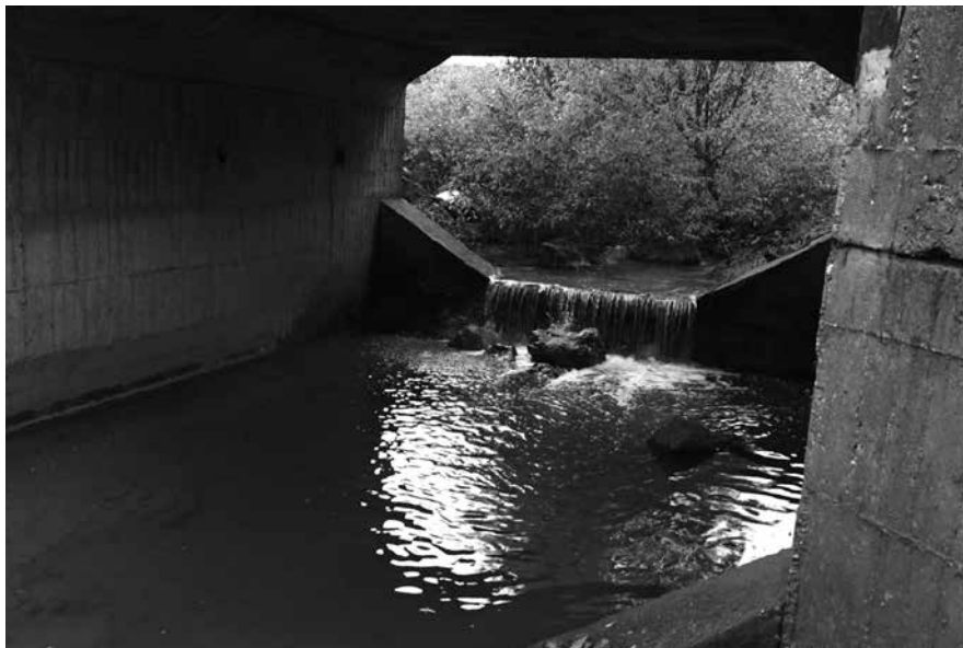
Most přes potok Manivier. (Foto: autor)
