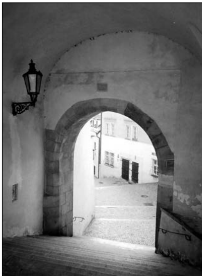
Praha-Hradčany, Radnická brána, vnitřní schodiště
