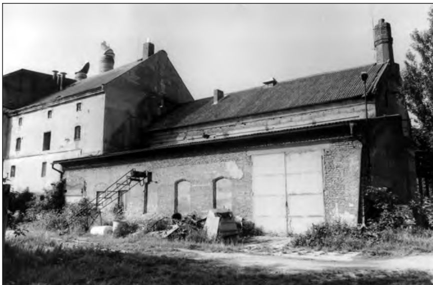
„Ty naše Benátky české...“ opravdu mají své kouzlo i při pohledovém podání, zdůrazňujícím původní účel současné sladovny jakožto pivovaru. V popředí varna se zbytkem varního komínu a dále pak strojovna s kotelnou (foto autora, 2000)
