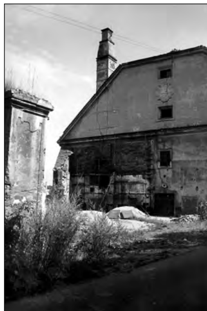
Průčelí zámeckého pivovaru v Brandýse nad Labem v podobě téměř současné. Štítu s polovalbou věvodí odstupňovaný varní komín (foto autora, 1985).
