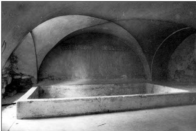
Stará část benátské sladovny s archaickým, hluboko do podlahy humna zapuštěným máčecím štokem (foto autora, 2000)
