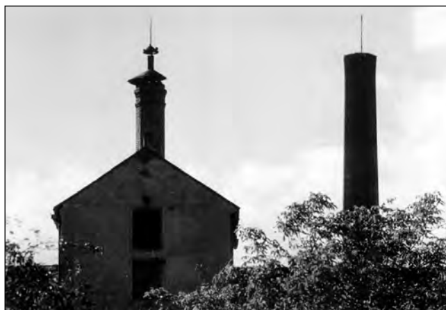
Jiný detailní obrázek, tentokrátě druhého cerhovického pivovaru, Mayerova, opět s komínem i párníkem na hvozdě. Obě takto zachycené vertikály už dnes nespátříme a zůstanou tak navždy zmizelým vjemem... (foto autora, 1984).
