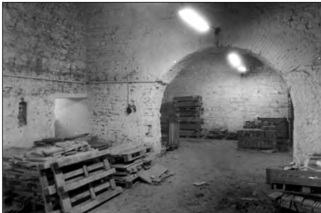
Závěr jednoho ze sklepních oddělení buštěhradského pivovaru i s ležnicí za ním. Klenby kámen i cihla – obojí ve vzájemné propojenosti a doplnění (foto autora, 2004)
