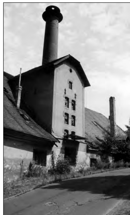
Z opačné strany brandýskému panskému pivovaru okázale dominuje sladovnický hvozď s párníkem. Při průjezdu silnicí kolem něj si nelze jeho výrazné vertikály nevšimnout (foto autora, 1985).
