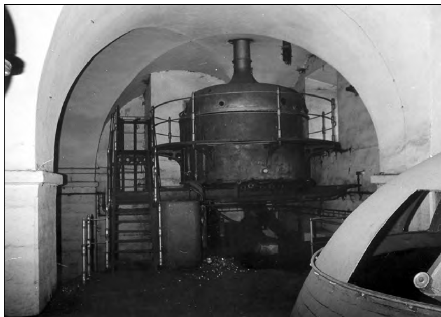
Brandýs nad Labem – dochovaná technologie na varně zámeckého pivovaru (foto autora, 1985)
