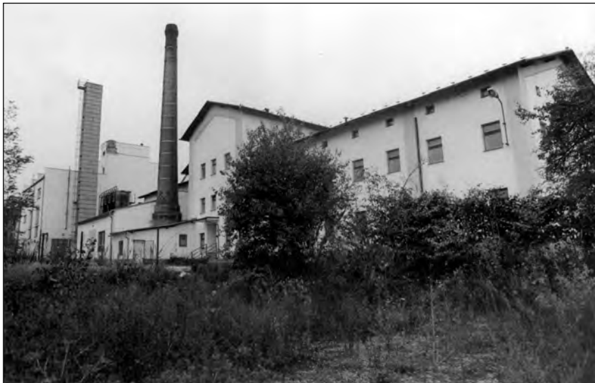
A konečně berounský pivovar dnešními očima. Nejbližší je zachycena sladovna s dominantním hvozdem (již bez koncového párníku), vlevo za komínem je nová varna – po skončení pivovarské činnosti byl její prostor upraven na kotelnu stáčirenských provozů. Hranolovitý komín je tak novodobým doplňkem, který nemá s původním pivovarem nic společného (foto autora, 2003).
