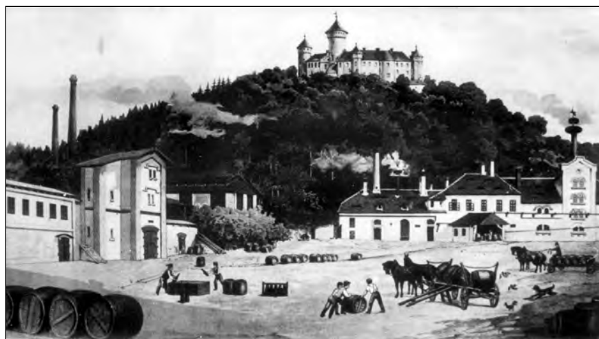
Dobová pohlednice vrchnostenského pivovaru na Konopišti se zámek na obzoru. Obrázek znázorňuje podnik ve vrcholném stadiu jeho činnosti v poslední třetině 19. století. V levém okraji je krásně vidět už modernější chladicí štok se spilkou a sklepy s výtahem na sudy ve věžovité přístavbě. Vlastní pivovar, středovým rizalitem dělený na část pivovarskou a sladovnickou, je rovněž již v pokrokovějším duchu obohacen o původní hmotovou záležitost, poněkud narušující sladovní hvozď (archiv autora).
