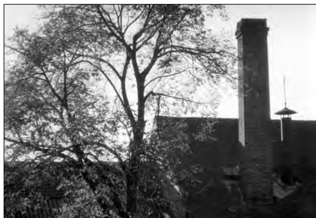
Detail téhož pivovaru v Cerhovicích s varním komínem a párníkem z kotle (foto autora, 1984)
