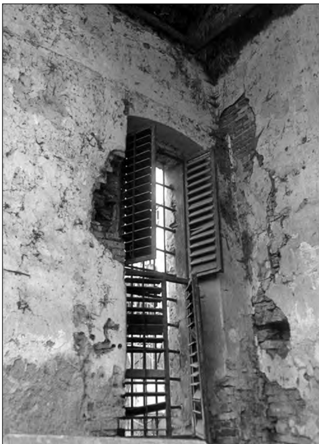
Varní okno v Cerhenicích (foto autora, 1985)
