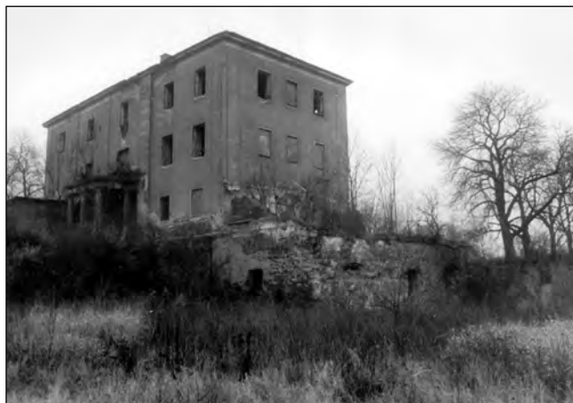
Brnky u Prahy s opuštěným a zdevastovaným zámekem s částmi pivovarských sklepů v předprsni panského sídla (foto autora, 1996)
