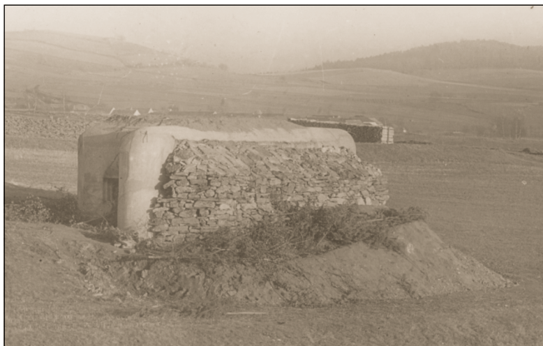
Výřez dobové pohlednice s objektem 197/77/A-180Z, u něhož se stavební firmě nepodařilo dokončit zemní zához. Čelní stěna je tak kryta pouze rovinaninou vyskládanou na sucho z kamenů.
