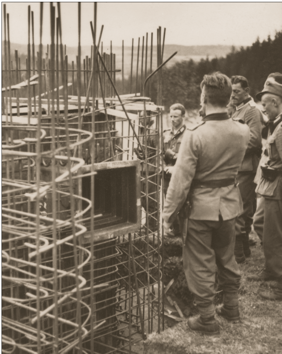
Pohled na levou stranu vyarmovaného objektu 196/32/A-160N u obce Veselí, jehož stavba nebyla dokončena v důsledku přijetí podmínek mnichovské dohody. Dobře patrné jsou téměř kolmé stěny výkopu, na jehož dně je položena betonová skořápka. V armování je již osazen rám střílny o hmotnosti 180 kg, který byl podepřen rámem z betonářské výztuže. Za výztuží je patrné rovněž vnitřní dřevěné bednění.
