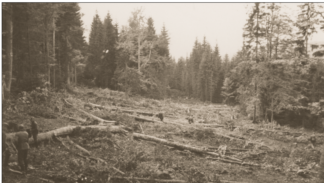
Pohled na čerstvě vykáčené průřeky v lesním masivu mezi Kubovou Hutí a Lenorou. Snímek byl pořízen od objektu 191/45/A-140N směrem k sousednímu řopíku č. 44. V místě před fotografem se původně nacházela paseka řídkce porostlá buky s průměrem kmene 20–40 cm, což vysvětluje nezvyklou šíři vykáčeného pásu lesa před objektem. Majitelem této lesní parcely byl František Wagner, Kubova Huť čp. 5. Vzadu ve smrkovém lese jsou již patrné průřeky ve standardní šíři (vlevo pozorovací průřek, vpravo střelecký průřek). Tato parcela již byla ve vlastnictví města Vimperk.
