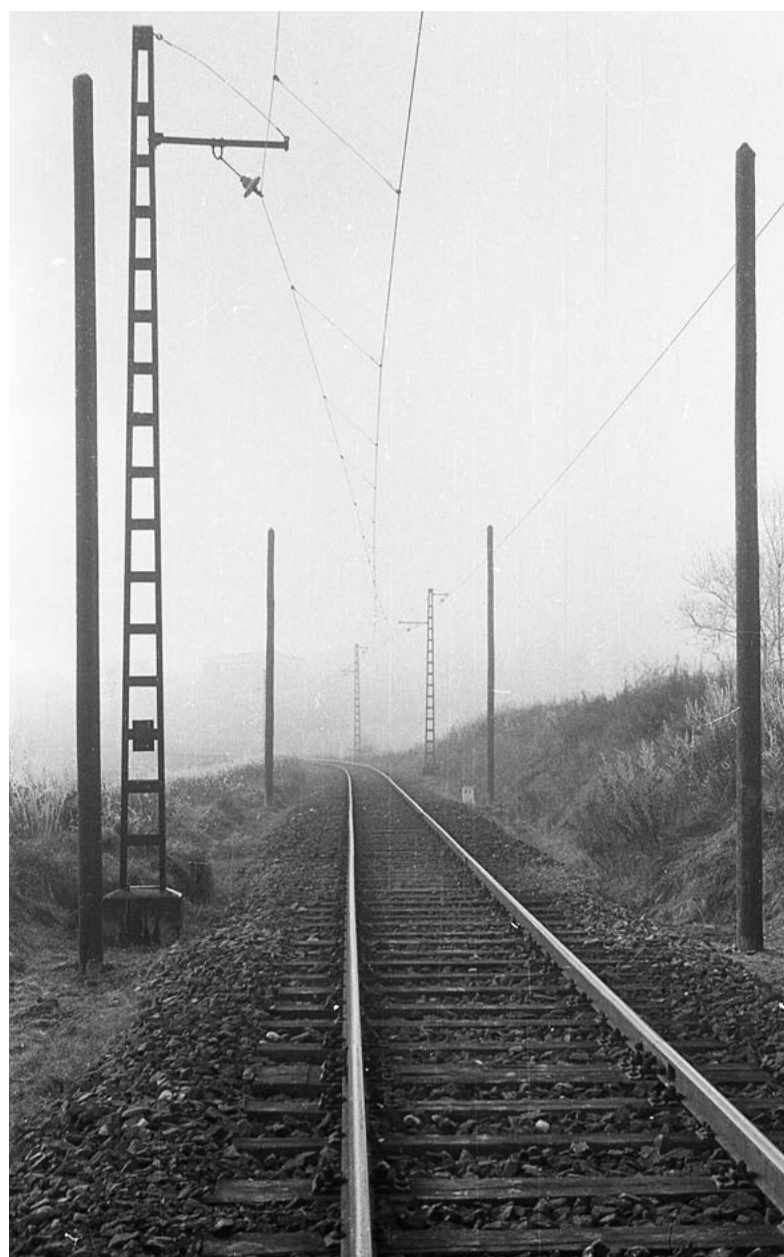
Náhrada původního trakčního vedení na trati Rybník–Lipno v roce 1952 v souvislosti s výstavbou vodní nádrže Lipno. Archiv EŽ Praha
