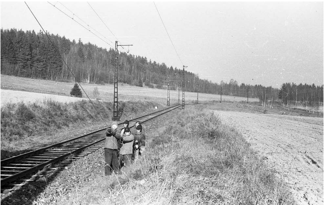
Nové trakční vedení 1,5 kV ss v úseku Rybník–Jenín. Archiv EŽ Praha
