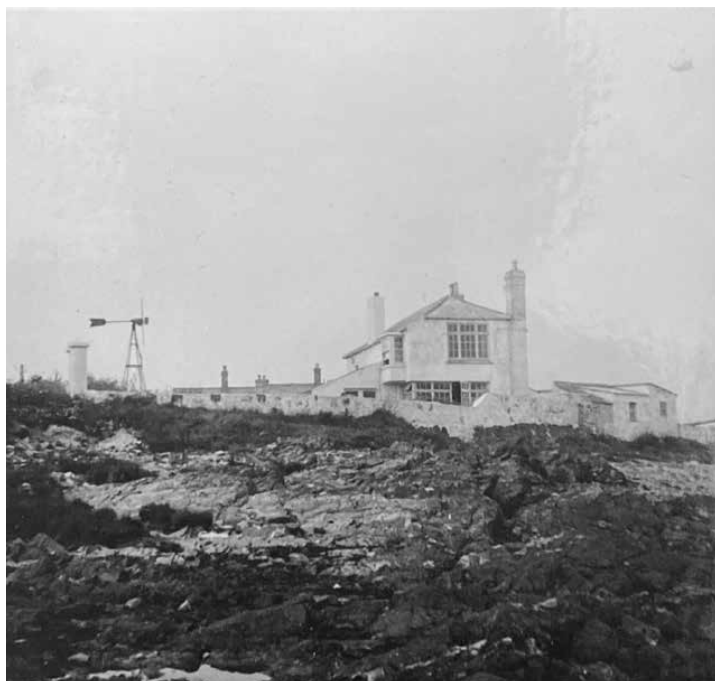
Strážní dům při odlivu. Za přílivu se moře dostalo až k domu. Povšimněte si větrné elektrárny.
