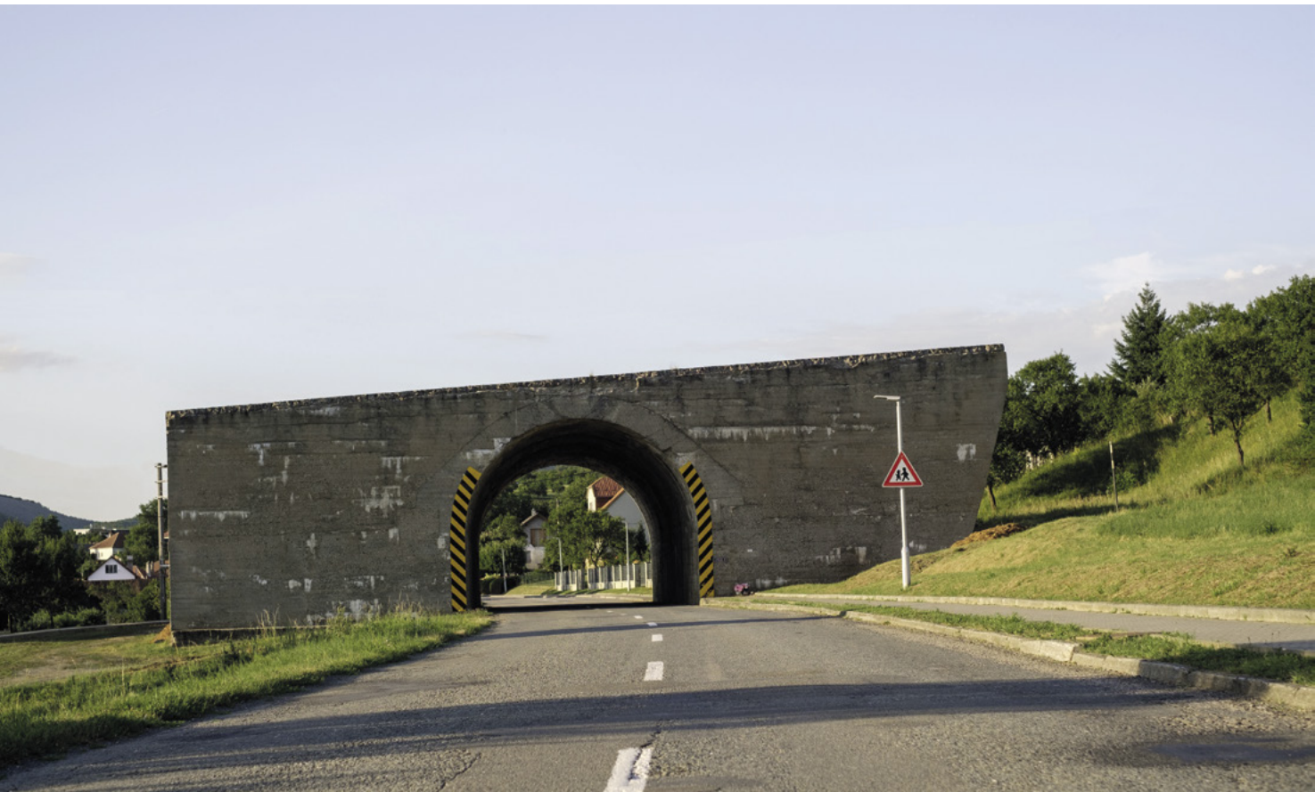
Pozůstatek nedostavěné Baťovy dálnice u Ludkovic na Zlínsku. V roce 2023 byl tento betonový podjezd zdemolován.
